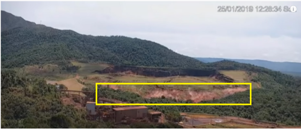
Figura 11- Terceiro estágio descolamento, levitação e rompimento eq bqrragem
