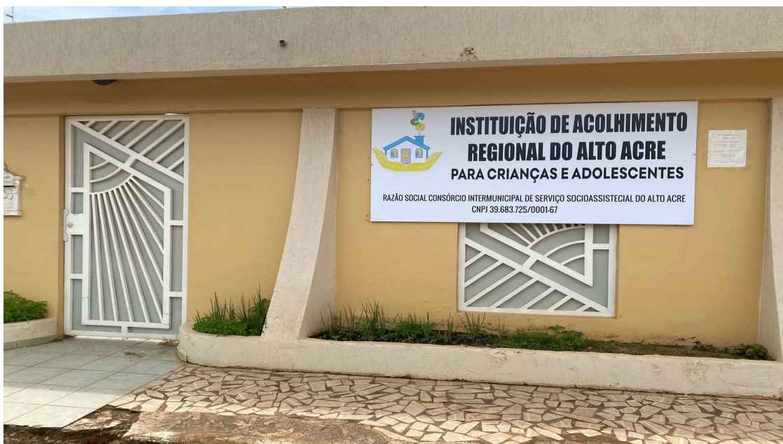
Figura 10 - Fachada da Instituição de Acolhimento Regional do Alto Acre, 2023.
