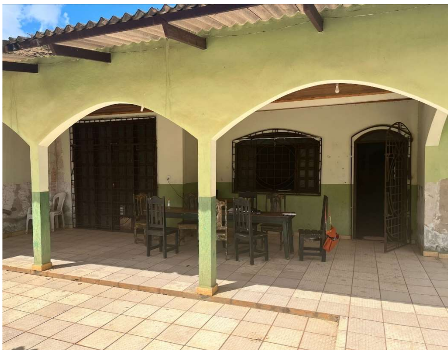
Figura 18 - Fachada da Casa-Lar Ester.
